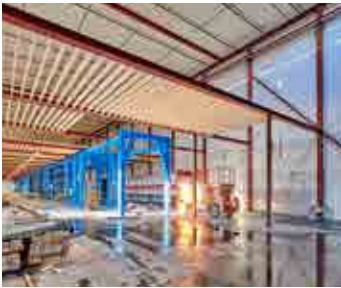
Arbetet pågår lite överallt i byggnaden, under våren 2025 ska det nya sågverket tas i bruk.
