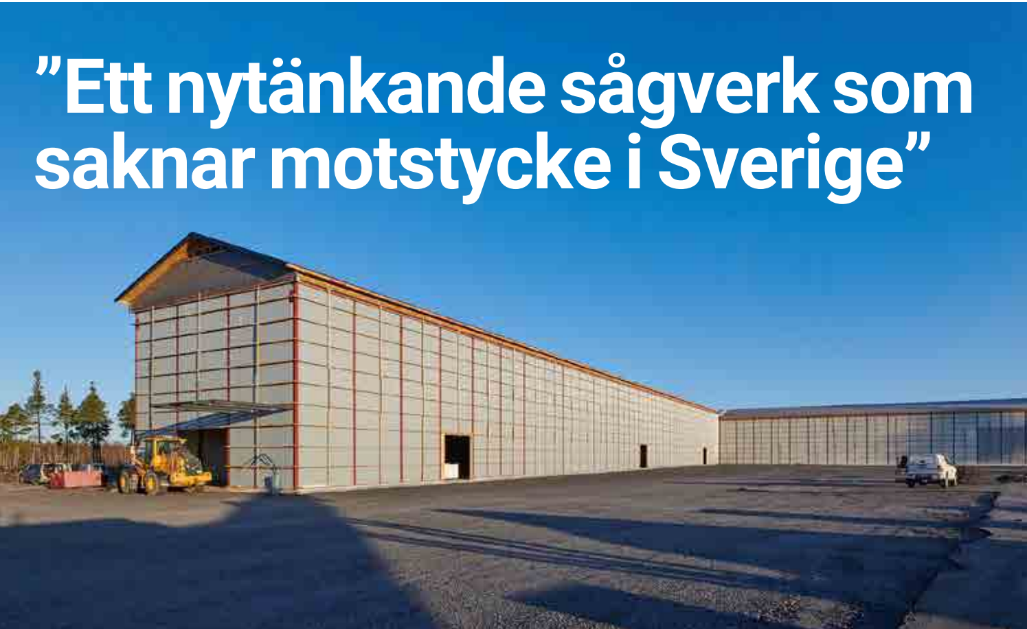
Ett nytt toppmodernrt sågverk byggs just nu i Sikfors.
