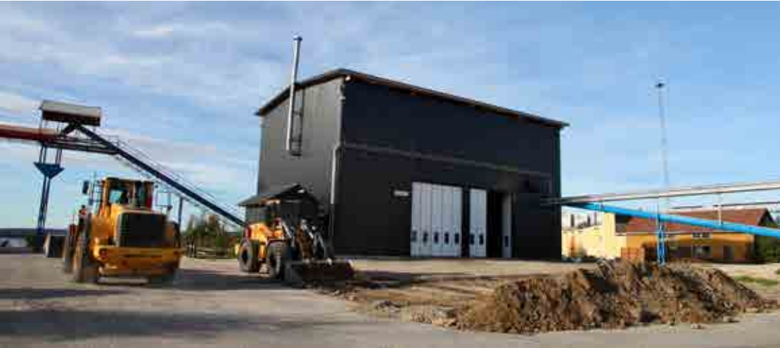
Pelletsverket körs av en enda operatör. Den relativt enkla processen är automatiserad i flera steg. Sågverkens restprodukt sågspån pressas till en klimatsmart pellets som ersätter fossila bränslen.
