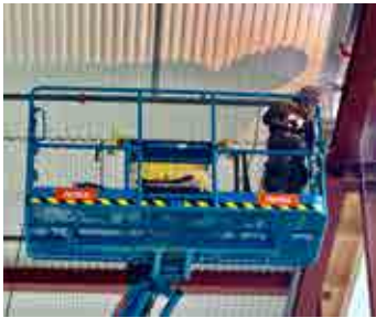
Svetsen blixtrar högt upp i stålstommen som ska bli det 220 meter långa byggnaden där den nya råsorteringen ska rymmas.
