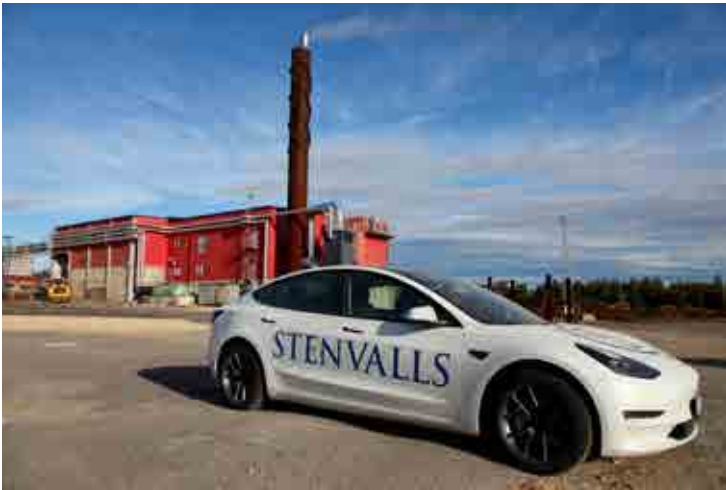
Energifrågan är hela tiden närvarande. Elbilar, ja. Och smart eldning i den nya effektiviserade pannan där restprodukter av alla de slag nyttjas.
