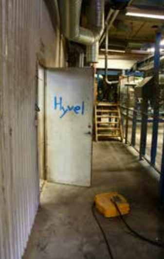
Dörren är tydlig.
