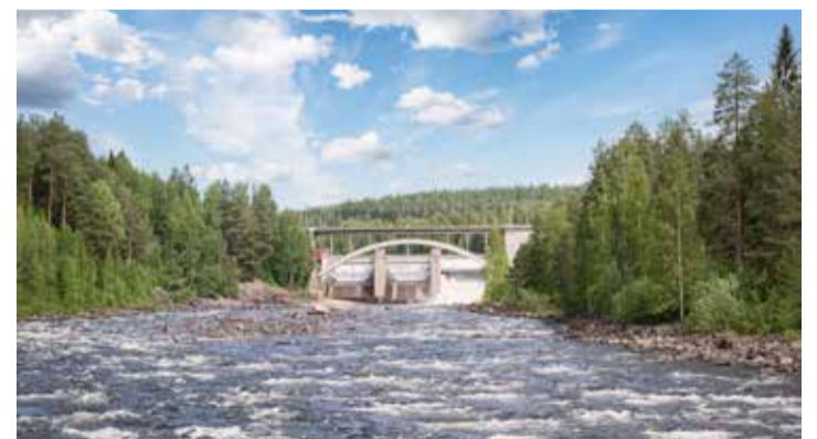
Forsen och kraftstationen i Sikfors.
