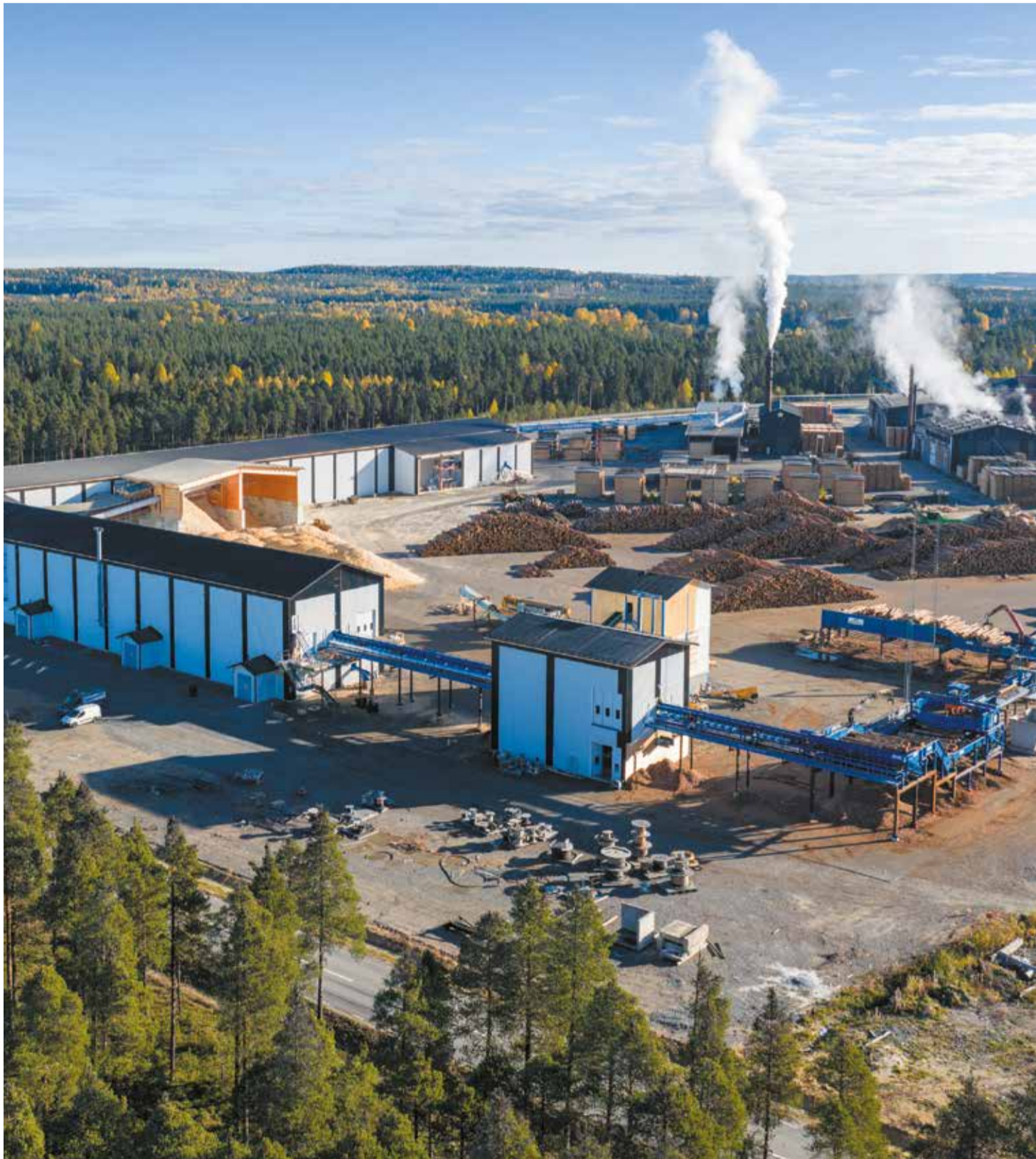
Den nya sågverksanläggningen i Sikfors har nu börjat tas i drift.
