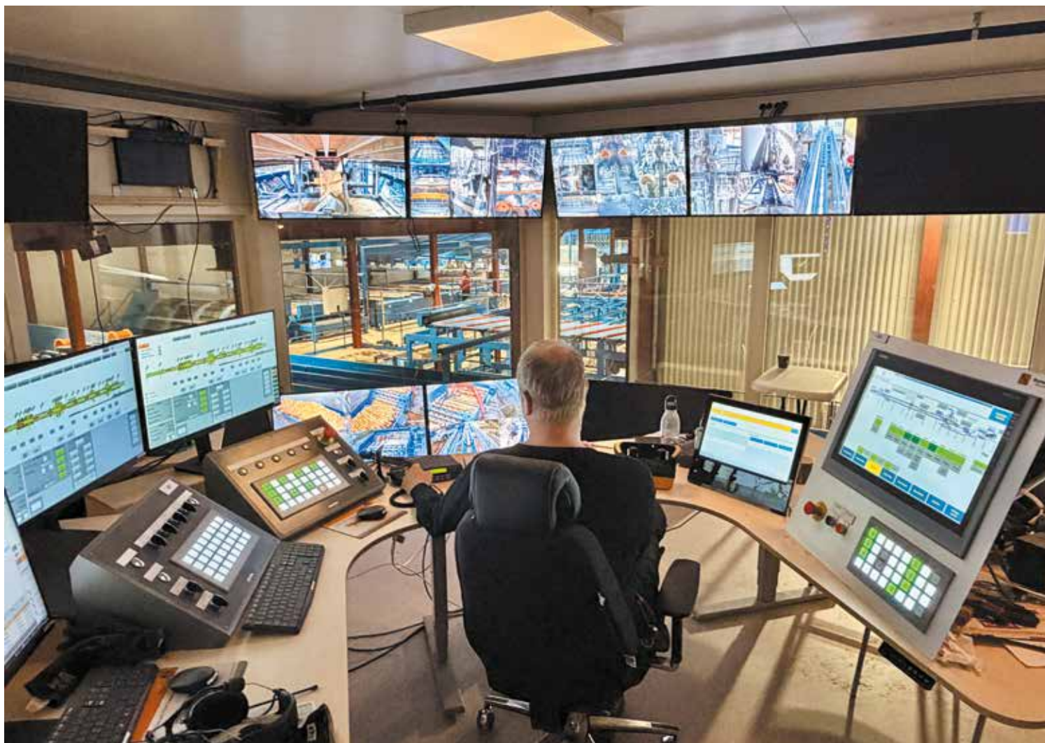
Från operatörsrummet övervakas produktionen i det nya toppmoderna sågverket i Sikfors.
